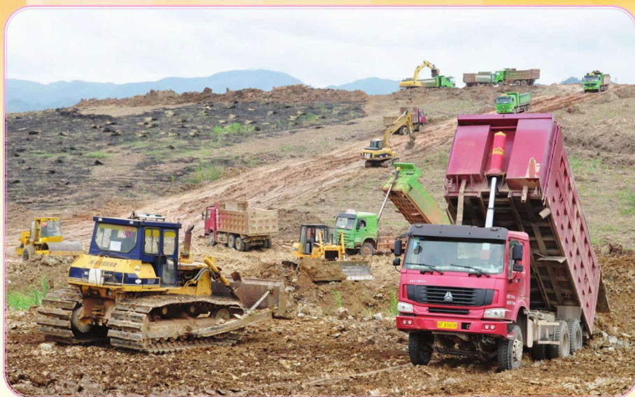
2015年2月,城中镇政府 实施推坡填沟建设甘蔗“双高” 生产基地
