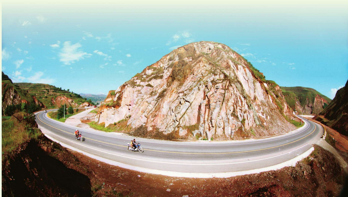
二级公路通县惠民（生成 摄）
