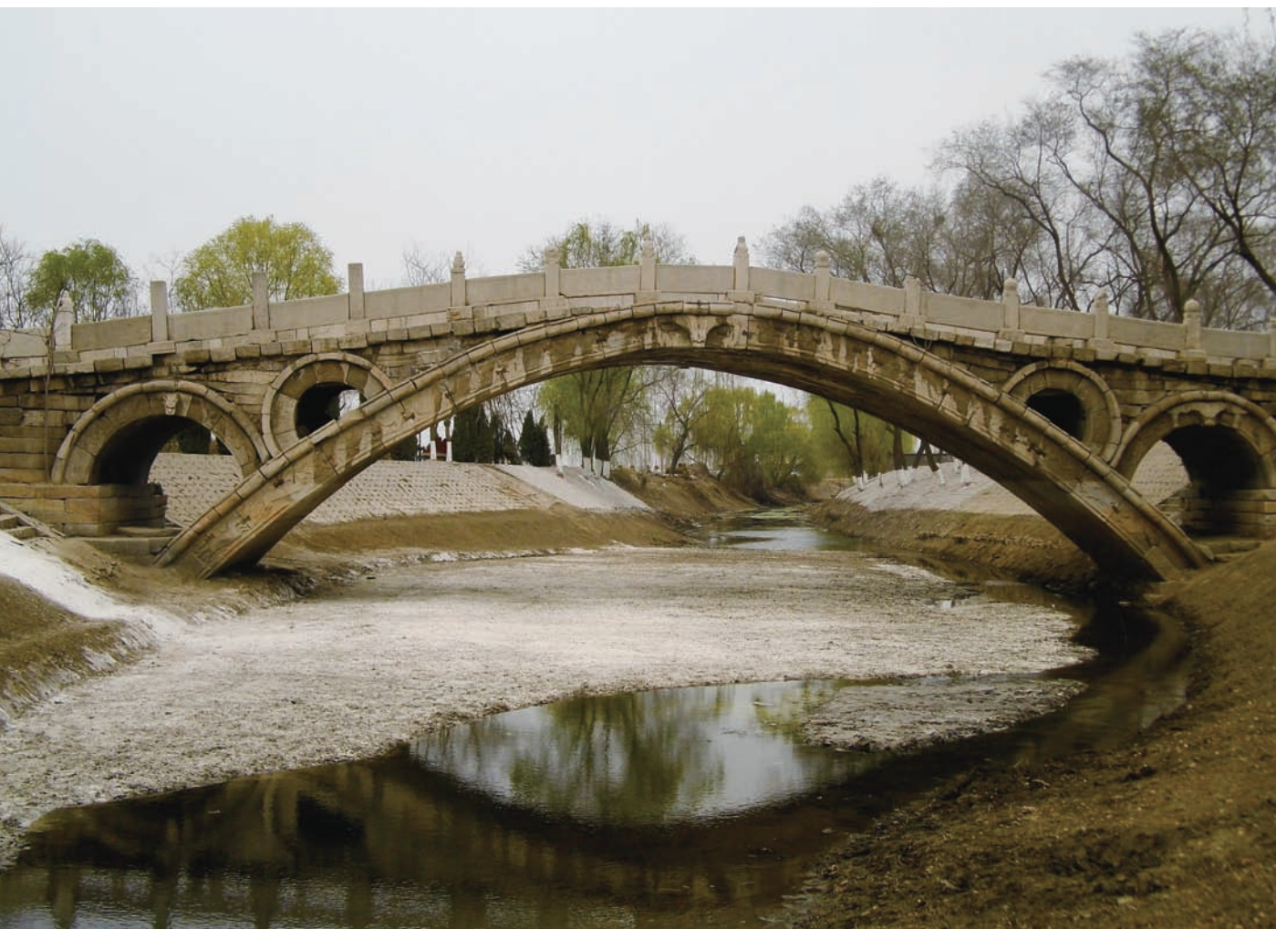
弘济桥全景（由南向北）
