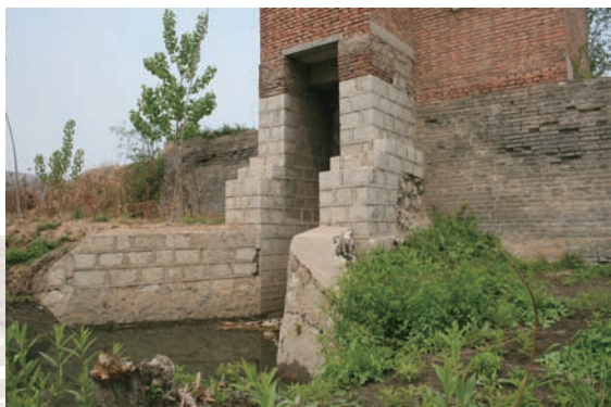
西八闸之润民闸
