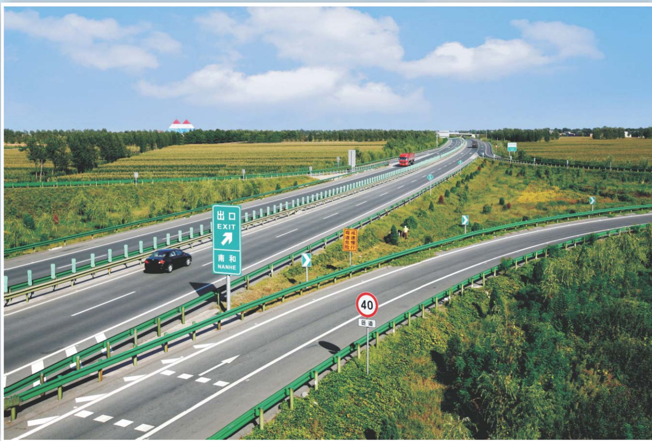
“邢临”高速南和出入口
