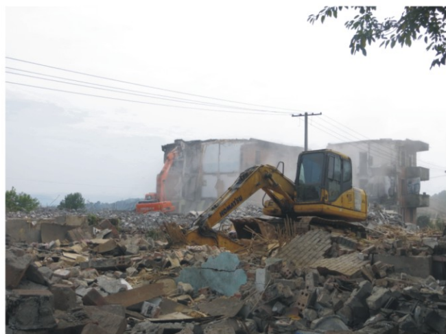
启动吉祥煤矿老井片区公租房项目
