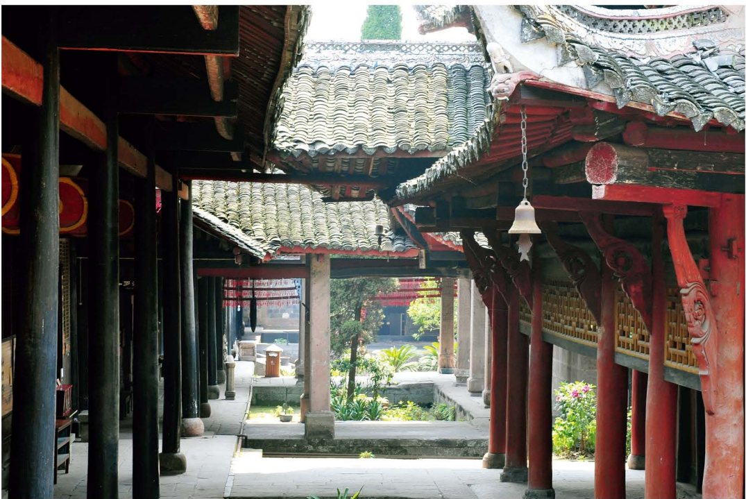
檐廊和连廊空间
