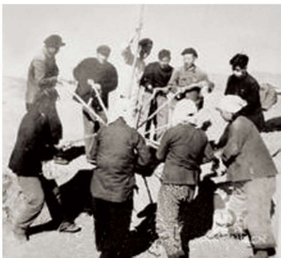
边区群众“齐心协力”用土法夯实公路路基（1948）
