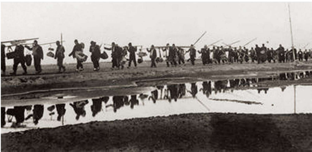
支前大军行走在刚抢修好的公路上（1948）
