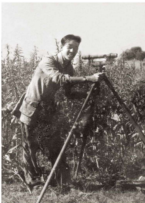
任丘公路段技术员张引兴用先进仪器测量平大公路（1949）
