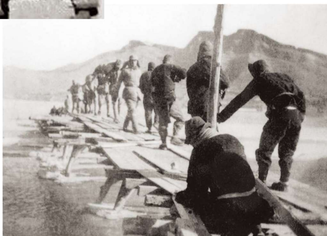
边区人民与冀察部队一起架设马水河便桥（1948）
