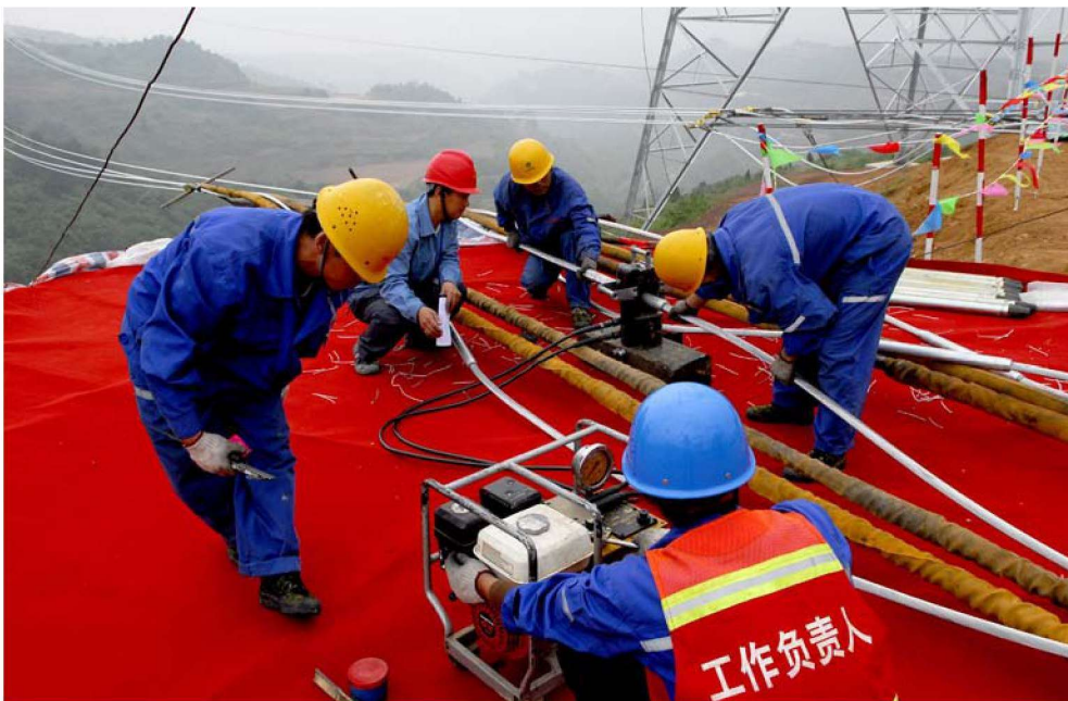
1000 千伏特高压工程放线地面压接作业现场
