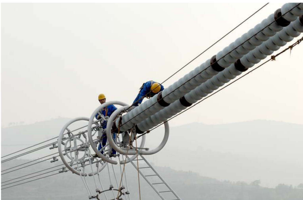
特高压电网工程作业现场
