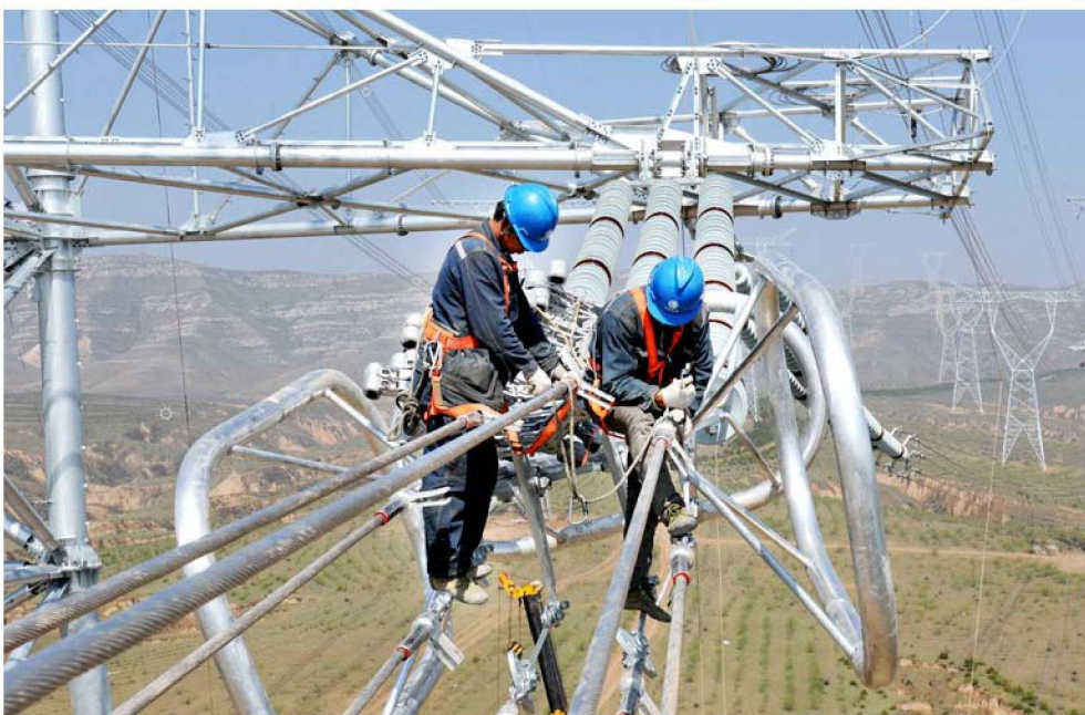
↘ 特高压电网工程作业现场
