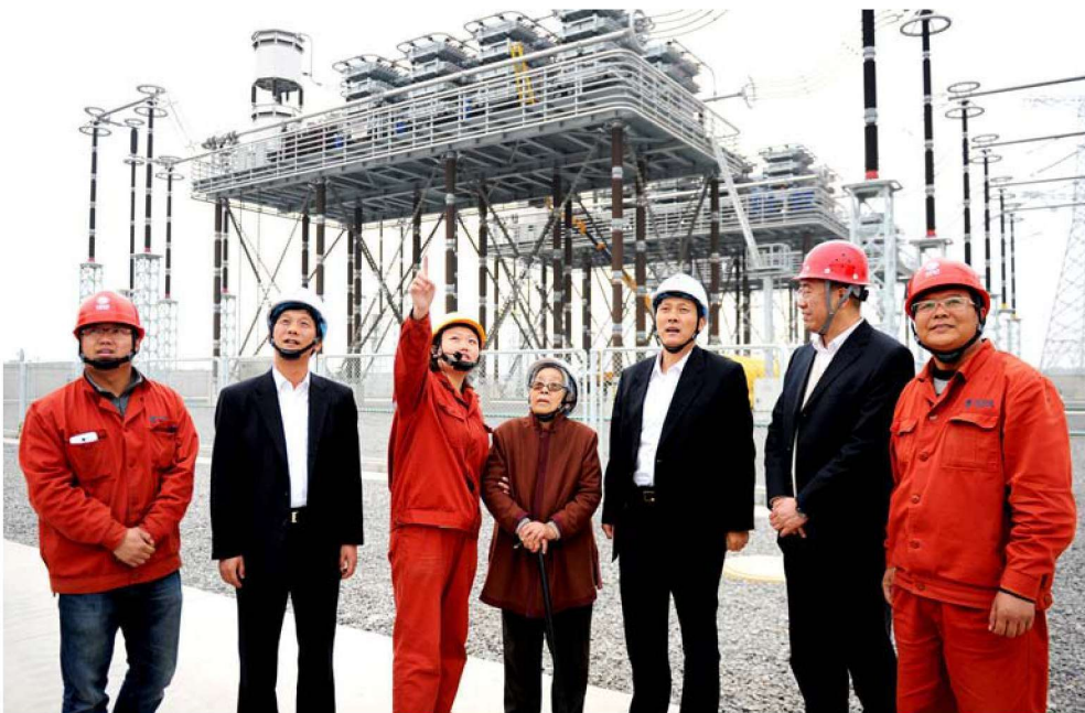
2013年10月29日，“全国创先争优优秀共产党员”“全国道德模范”解黎明参观1000千伏特高压长治变电站
