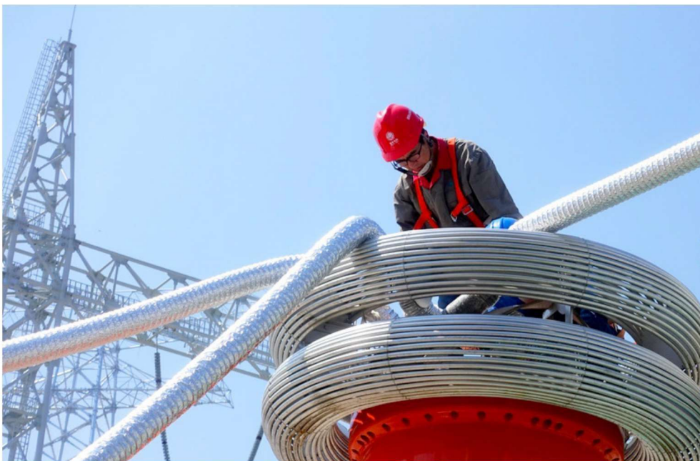
蒙西—天津南 1000 千伏特高压输变电工程晋北 1000 千伏变电站作业现场
