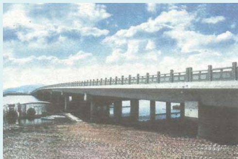
投入使用的漩门湾大桥
