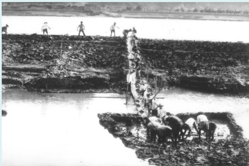
木制溜板、竹制推筒，用于围涂筑塘
