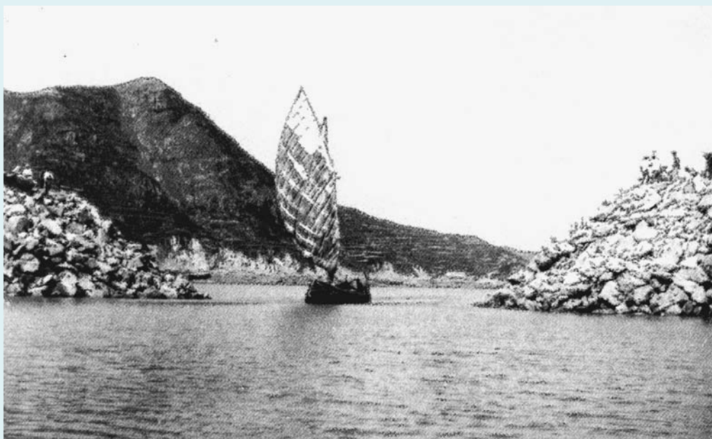
漩门港截流施工景象，南北两坝端民工在抛石时运输船过港，南岸空白处为开岩山场
