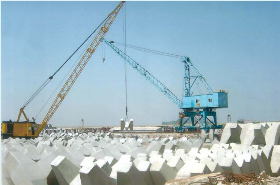
吊机吊装安放海堤外坡水泥预件“扭王字”块
