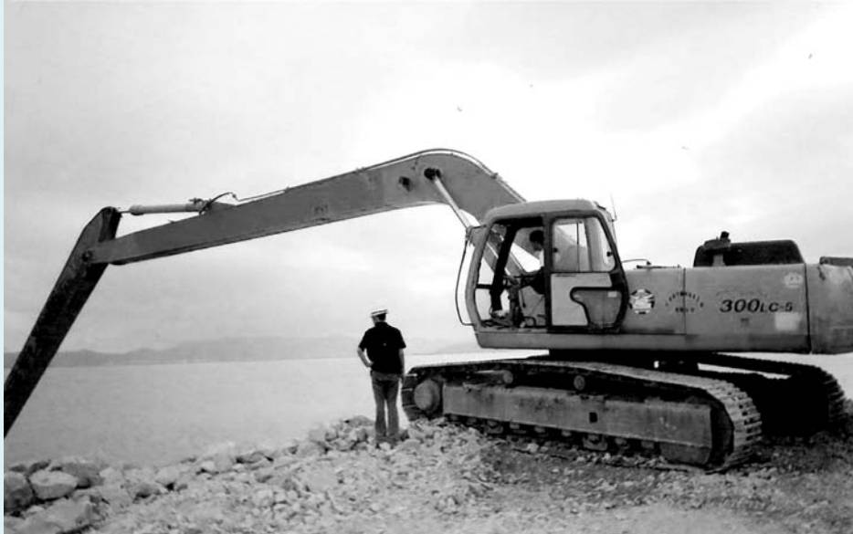
挖掘机在三期海堤为安装炸药打孔。海堤涂面高程低，堤基为软淤泥。为处理堤基淤泥，采用爆破挤淤置换法，即用爆破把淤泥挤去，用石块回填筑堤
