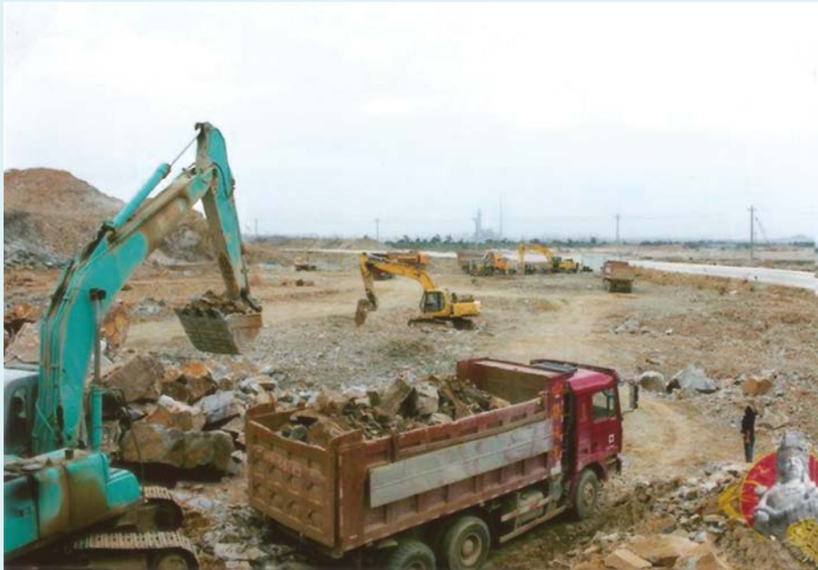
挖掘机挖土石装载
