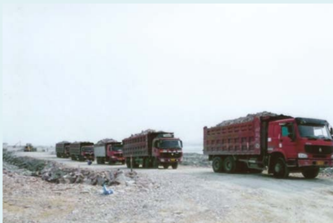
载重汽车运土石筑堤、筑坝
