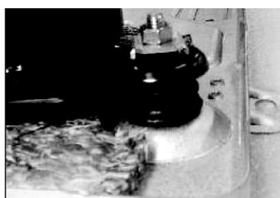
图 1-1-10 拧紧压缩机机脚螺母
