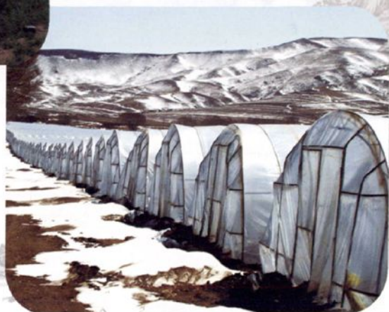
中棚建设工程
