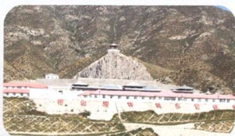
抽水蓄能电站
