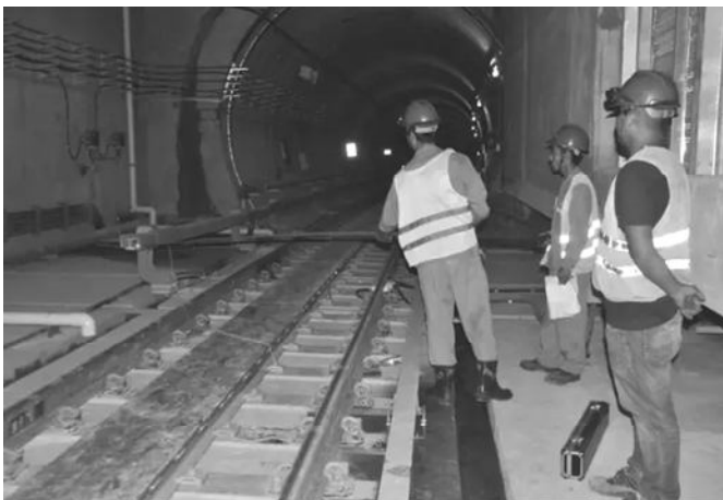
图 1-4 地铁验电操作
