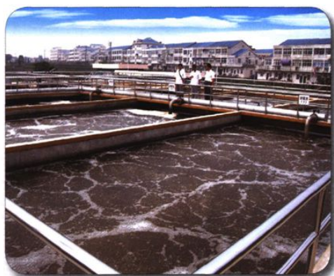
土桥污水处理厂
