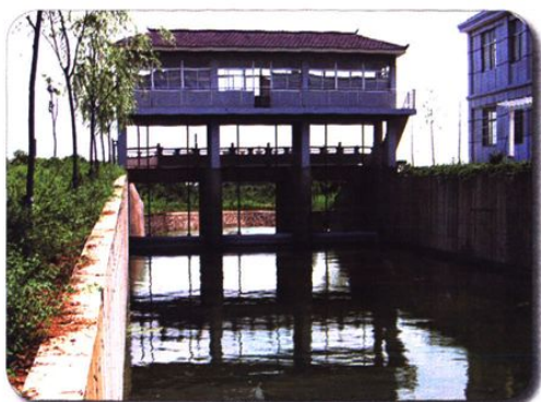
淳化东焦水库泄洪闸
