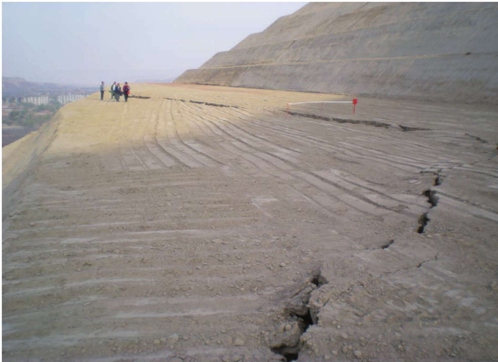
永靖县二房台滑坡后缘圈椅状拉张裂缝
