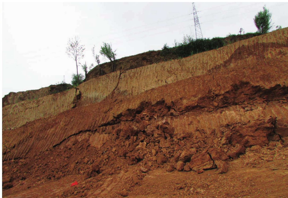
十天高速 K645+482~740m 滑坡剪出口
