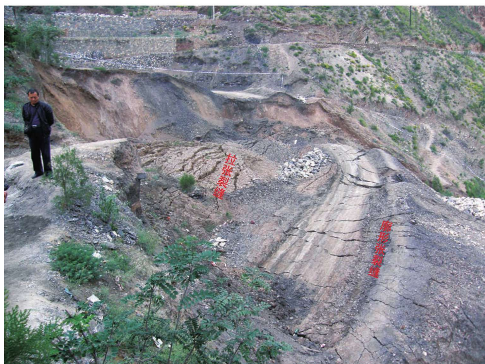
滑坡前缘扇形张裂缝及后部拉张裂缝
