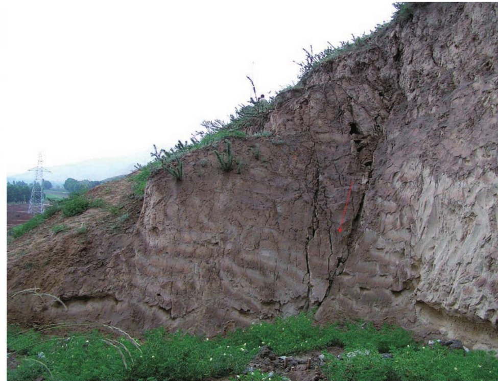
滑坡后缘拉张裂缝及楔形体
