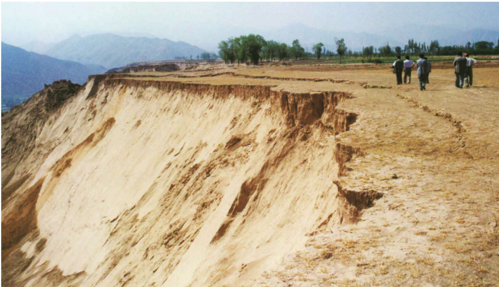
滑坡后壁、擦痕及牵引性（拉张）裂缝
