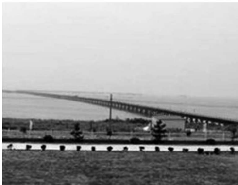
图 1.4 世界最长跨海大桥——青岛海湾大桥
