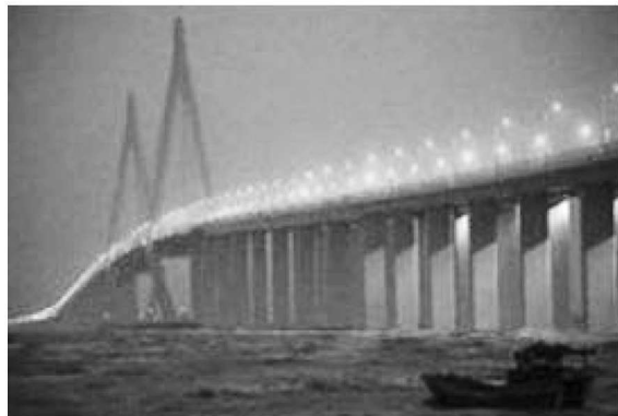
图 1.5 世界第三长跨海大桥——杭州湾跨海大桥
