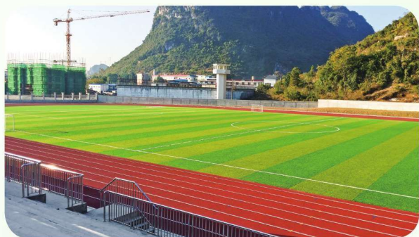
2015 年 1 月，罗城高中运动场竣工投入使用
