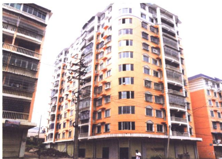
城南大道西段的12层电梯楼
