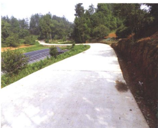
朱家场镇茅坡村通组路、连户路 已实现硬化
