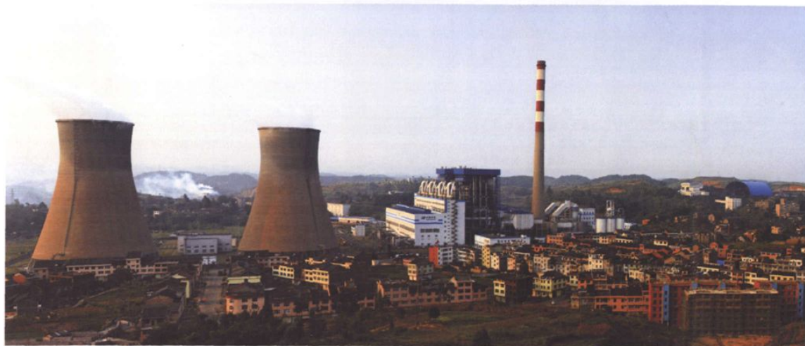
贵州华电大龙2×30万千瓦火电厂
