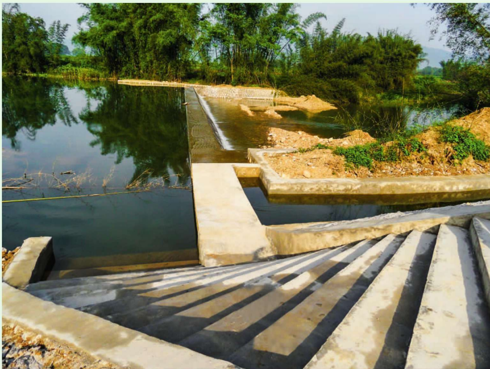
◆ 龙岸镇莲花村上莲花屯八架车河坝
