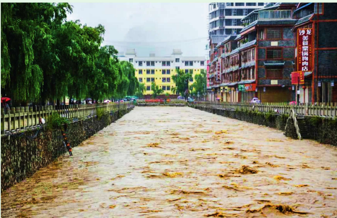
◆ 县城西门河防洪工程
