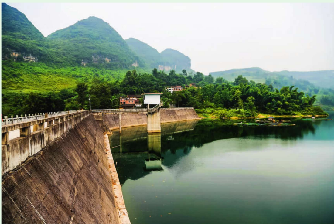
◆ 除险加固后的卡马水库大坝
