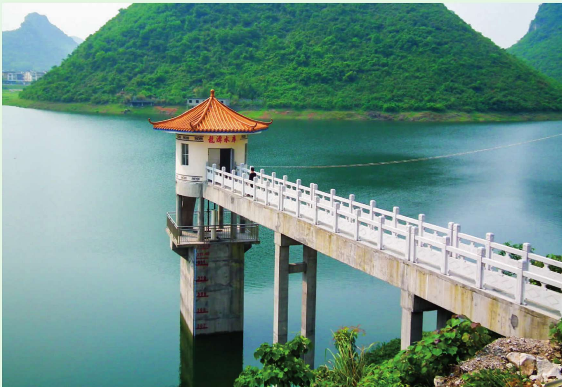
◆ 龙潭水库放水塔
