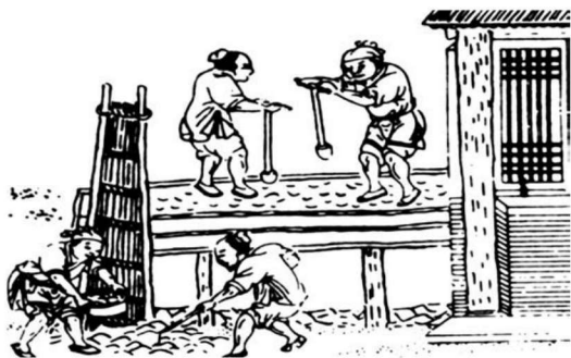
图 1-2 古代版筑夯土筑墙图
