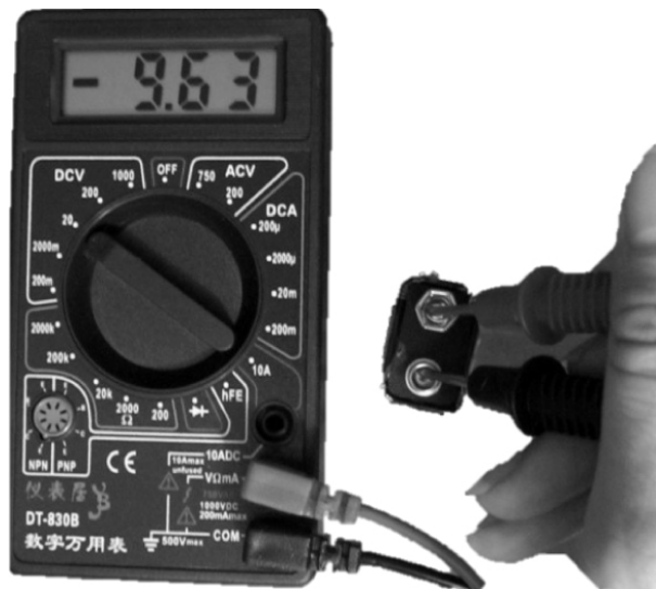
图 1-1-2 测量蓄电池电压
