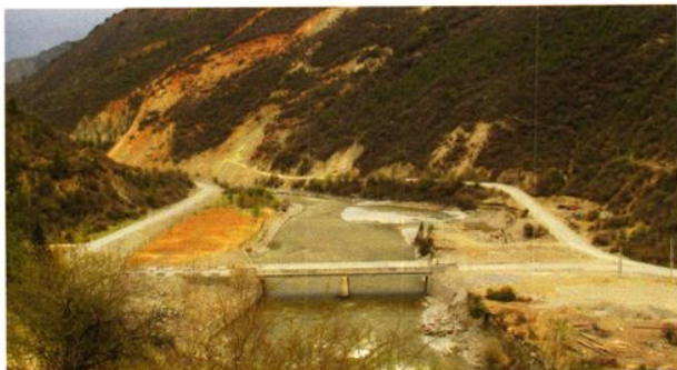
甘（孜）白（玉）公路219段改造工程
