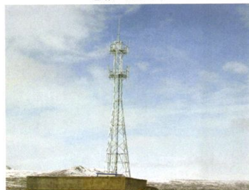
移动通信基站
