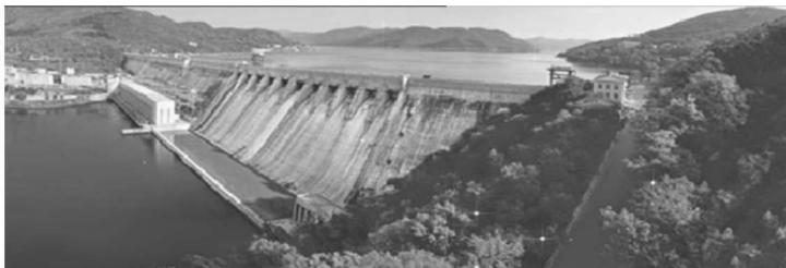
\* 丰满水库近照，丰满水库是中国东北大型水库，又称“松花湖”。位于吉林省吉林市东南 24 千米处。有铁路、公路相连。始建于 1937 年，经 20 世纪 50 年代以来的改造、扩建，已建成以发电为主，兼有防洪、灌溉、航运、养殖、旅游之利的水利枢纽工程。水库大坝高 95 米，长 1080 米。
