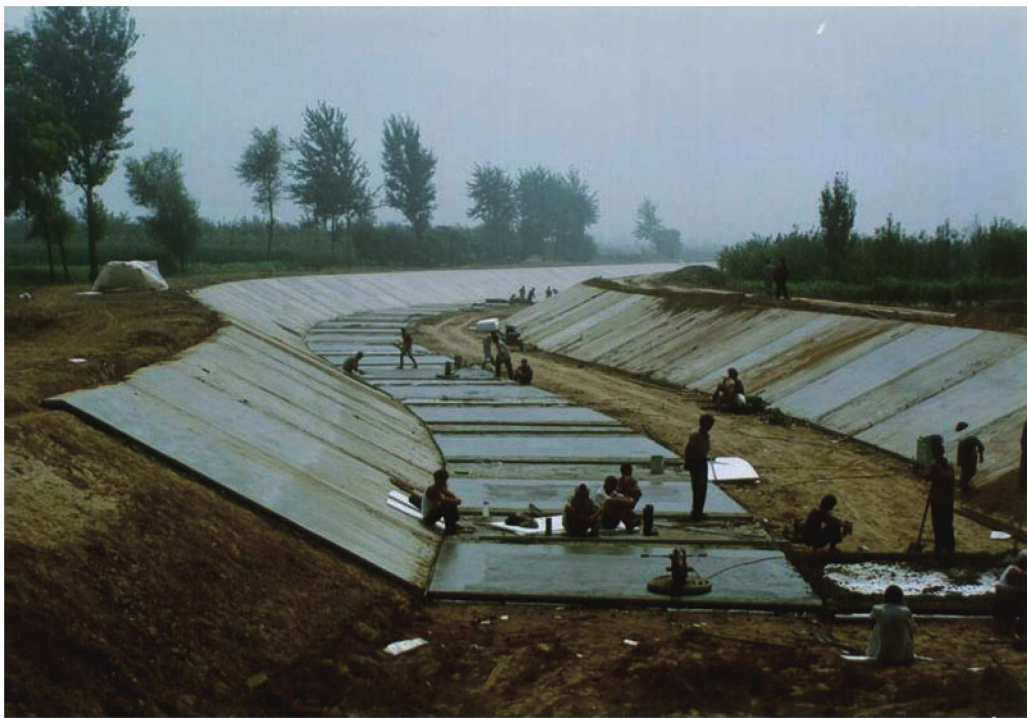
2000 年，建设中的石津灌区四千渠
