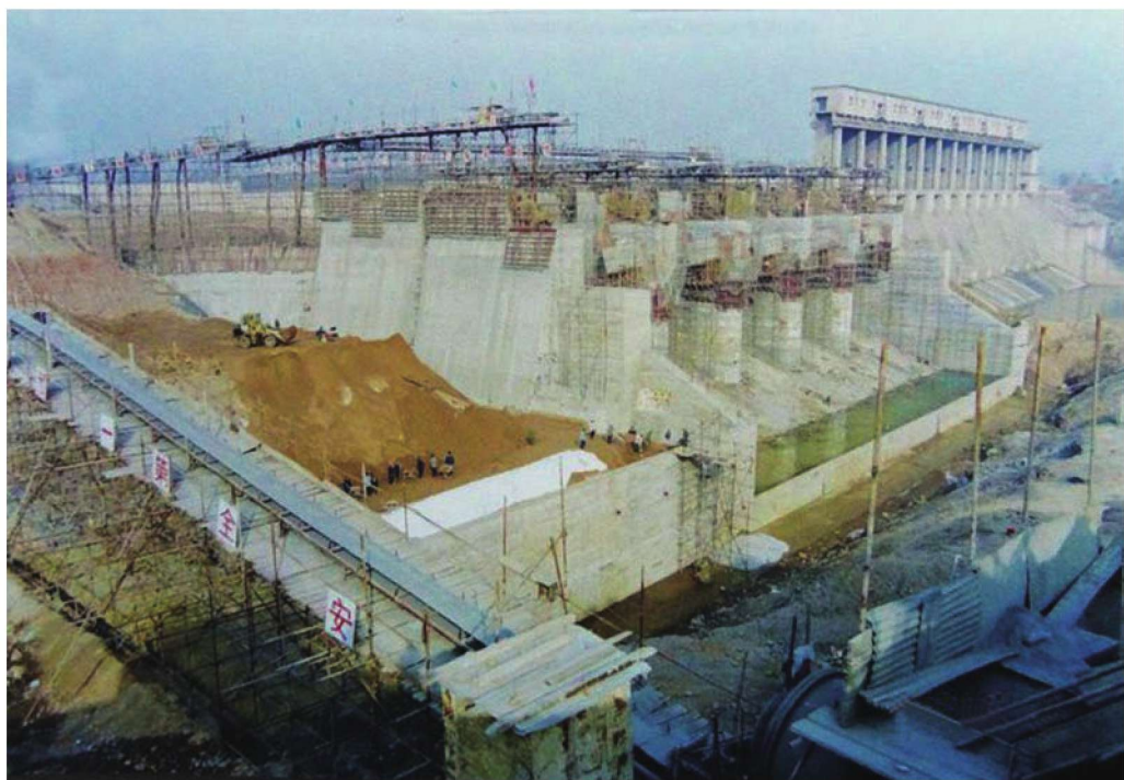
2000 年 12 月 6 日，黄壁庄水库除险加固工程新增非常溢洪道施工现场
