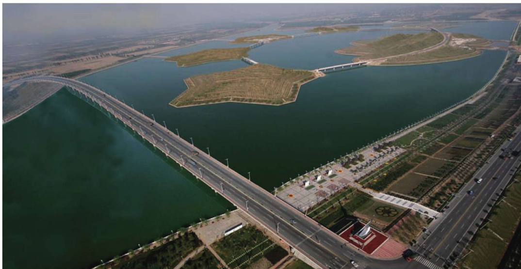
滦河迁安城区段生态防洪工程
