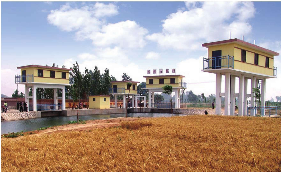
邯郸市漳滏河灌区钟楼寺枢纽
