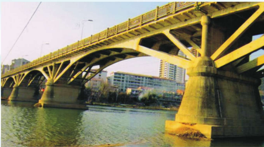
1989年5月建成通车的 东门大桥
