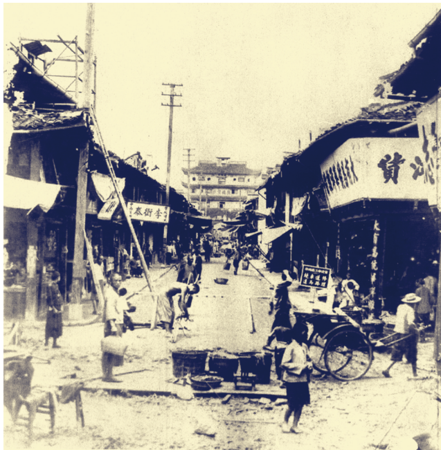
1935 年镇明路改建马路
