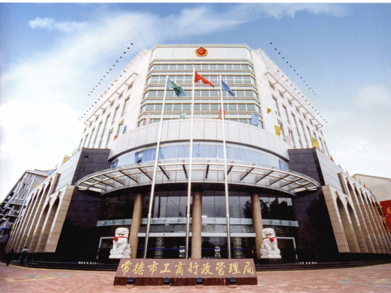
常德市工商行政管理局机关办公楼位于常德市武陵区武陵大道248号，始建于2002年，2003年竣工，土地面积8189.23平方米，建筑面积8271.18平方米，总投资2481.22万元
