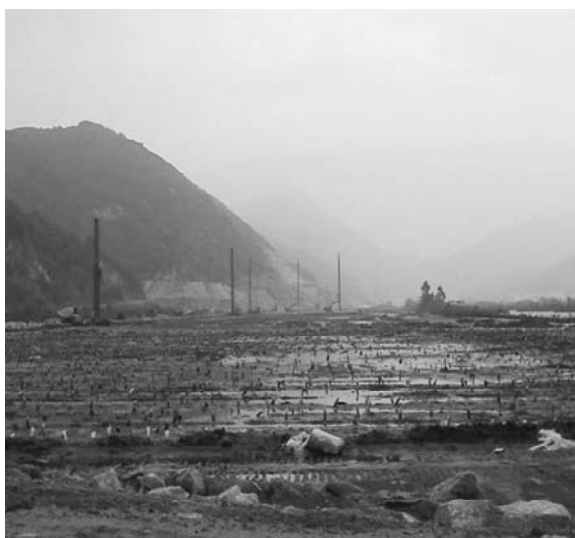
塑料排水板施工
