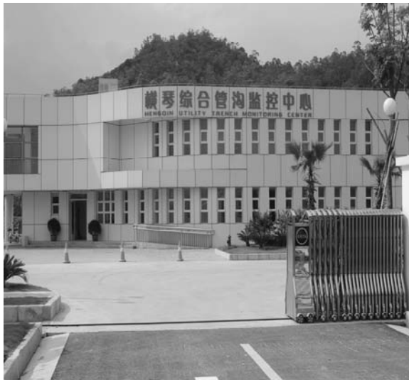
环岛北路综合管廊监控中心
