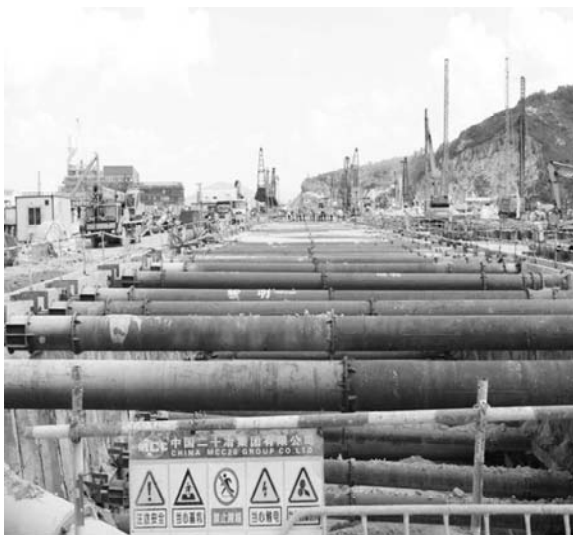
综合管廊基坑支护
