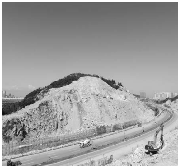
环岛东路边坡施工
