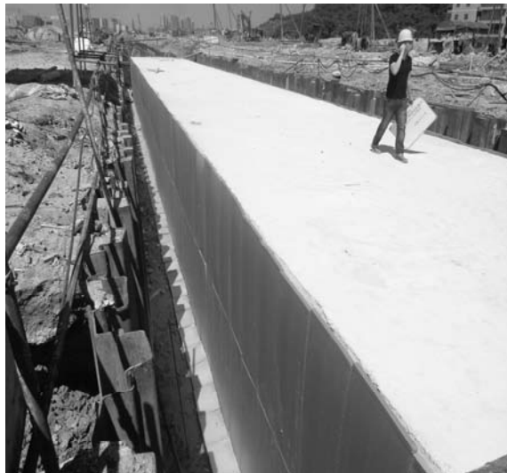
综合管廊防水施工
