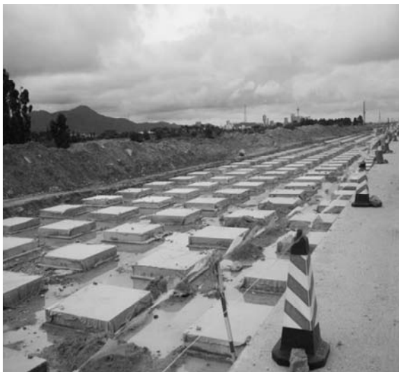
控沉疏桩软基处理
