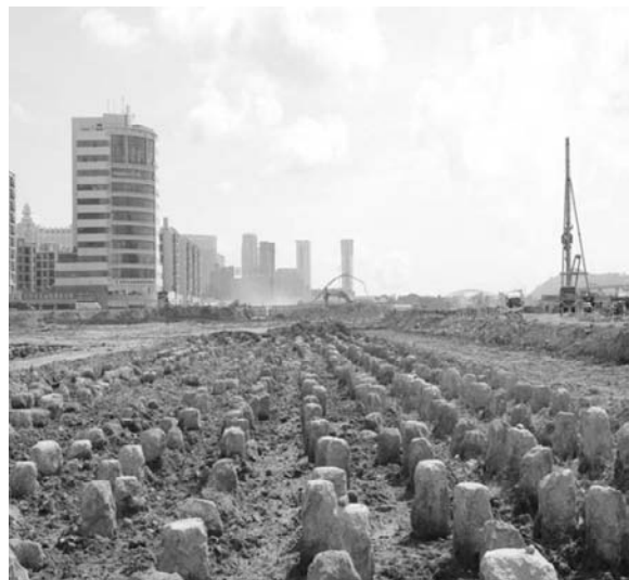
CFG 桩软基处理
