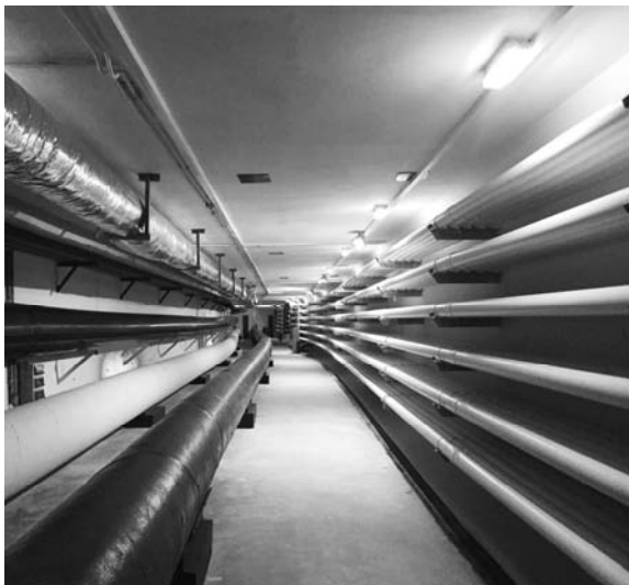
综合管廊内景
