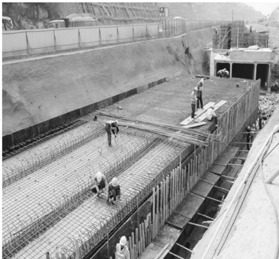
综合管廊结构施工
