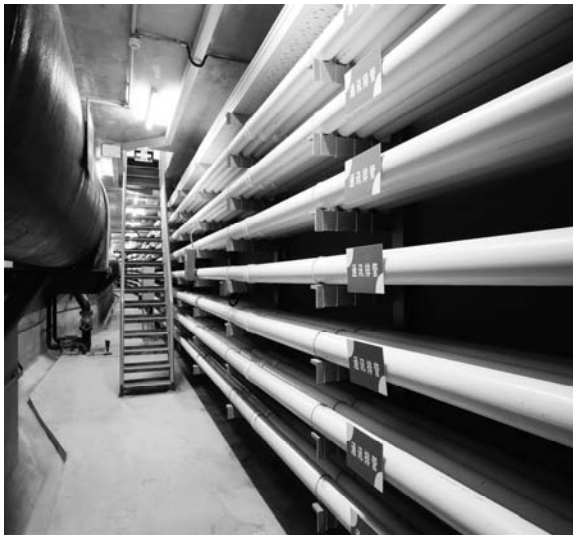
中心南路综合管廊
