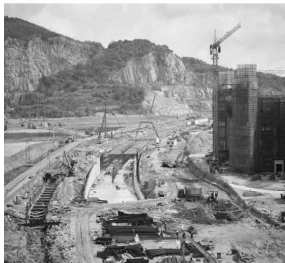
下穿地道施工
