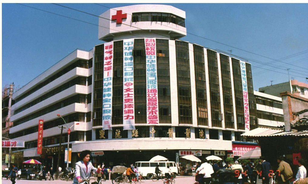
1994 年 4 月 27 日，医院淳化街院区门诊综合楼竣工
