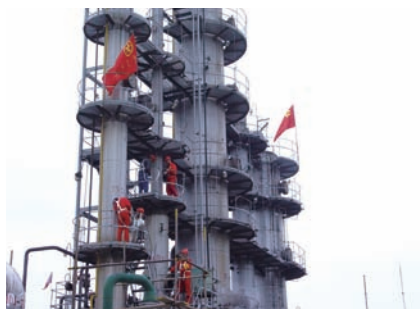
青年突击队检查吸收塔
