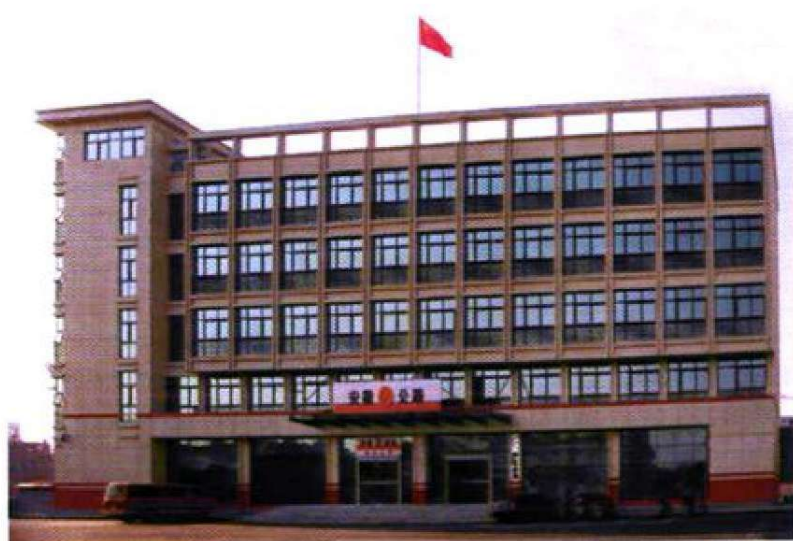
▲ 巢湖市公路管理局庐江分局办公大楼
