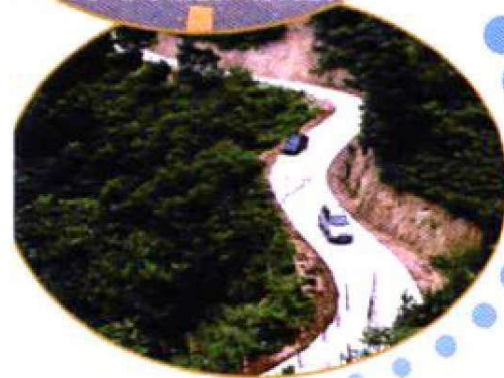
汤池镇“村村通”公路
