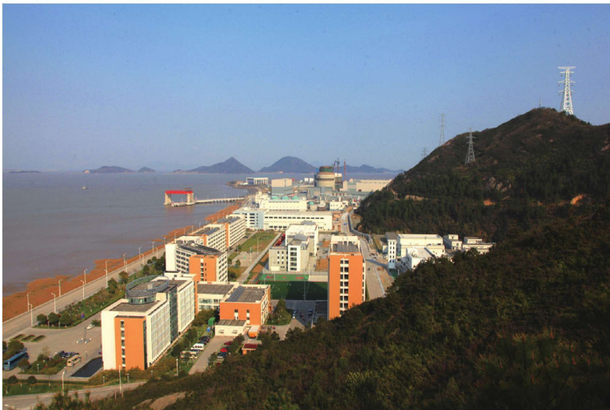
三门核电厂北区现状(摄于 2014 年)
