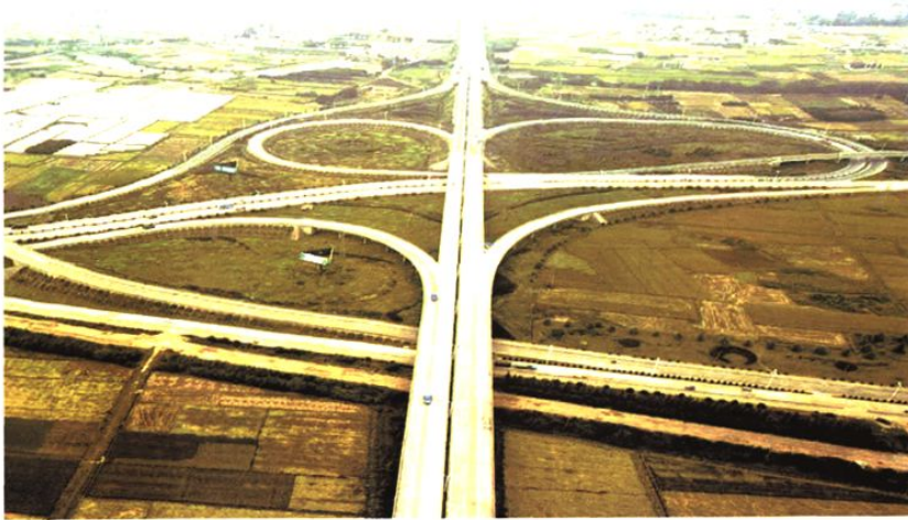
320 国道衢州段龙游九里立交桥航拍图
