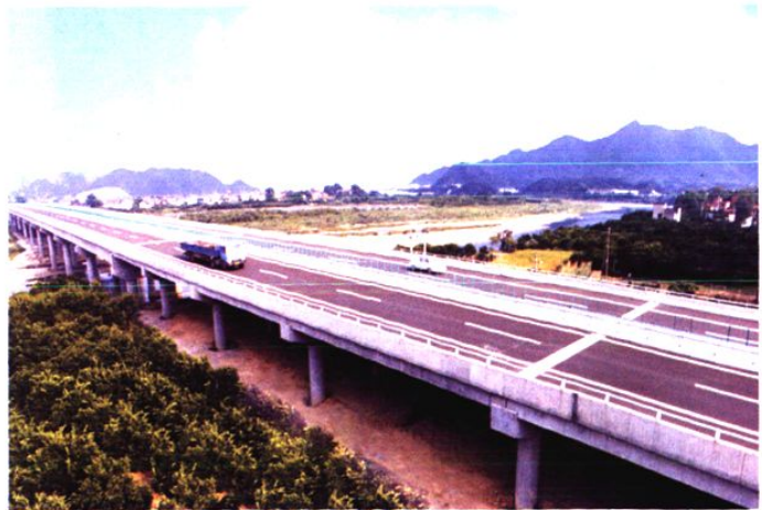
杭金衢高速公路常山特大桥 G60沪昆高速271K (2006.10.18摄)
