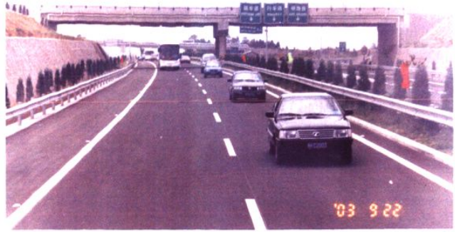
2003年9月22日，杭金衢高速全线贯通
