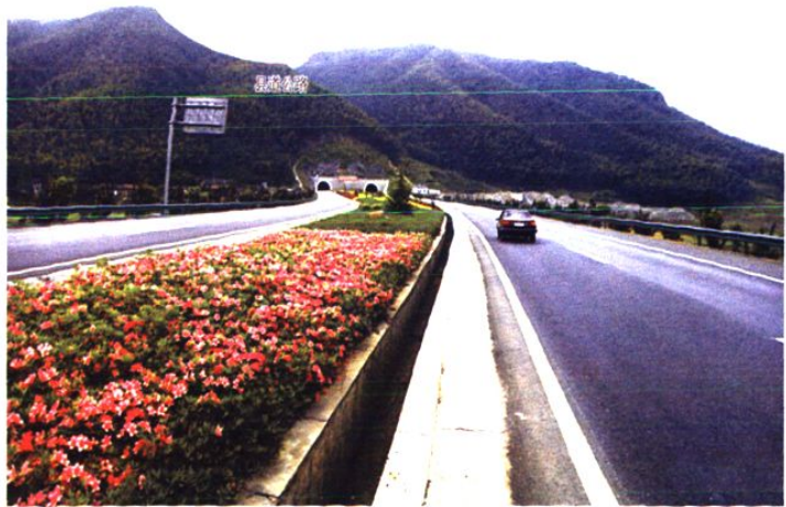
205 国道常山至江山一级公路
