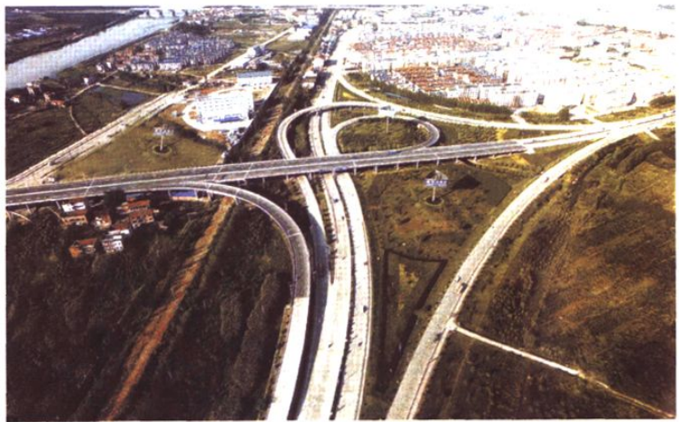
320 国道衢州市区落马桥鸟瞰图
