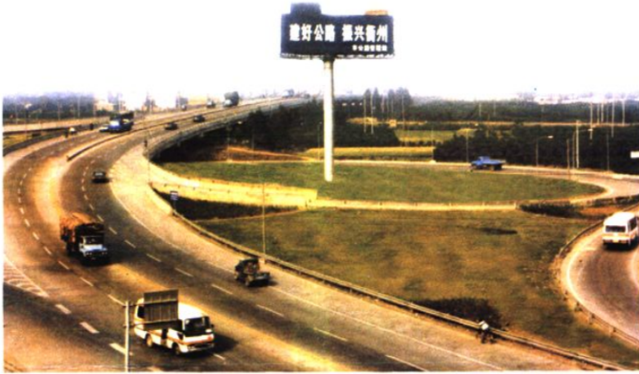
双港公铁立交桥（2004.5摄）
