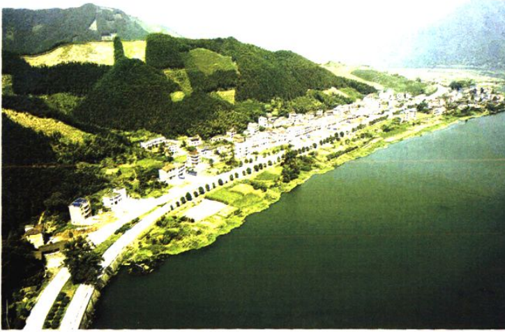
205 国道常山石门坑路段生态公路鸟瞰图1760K
