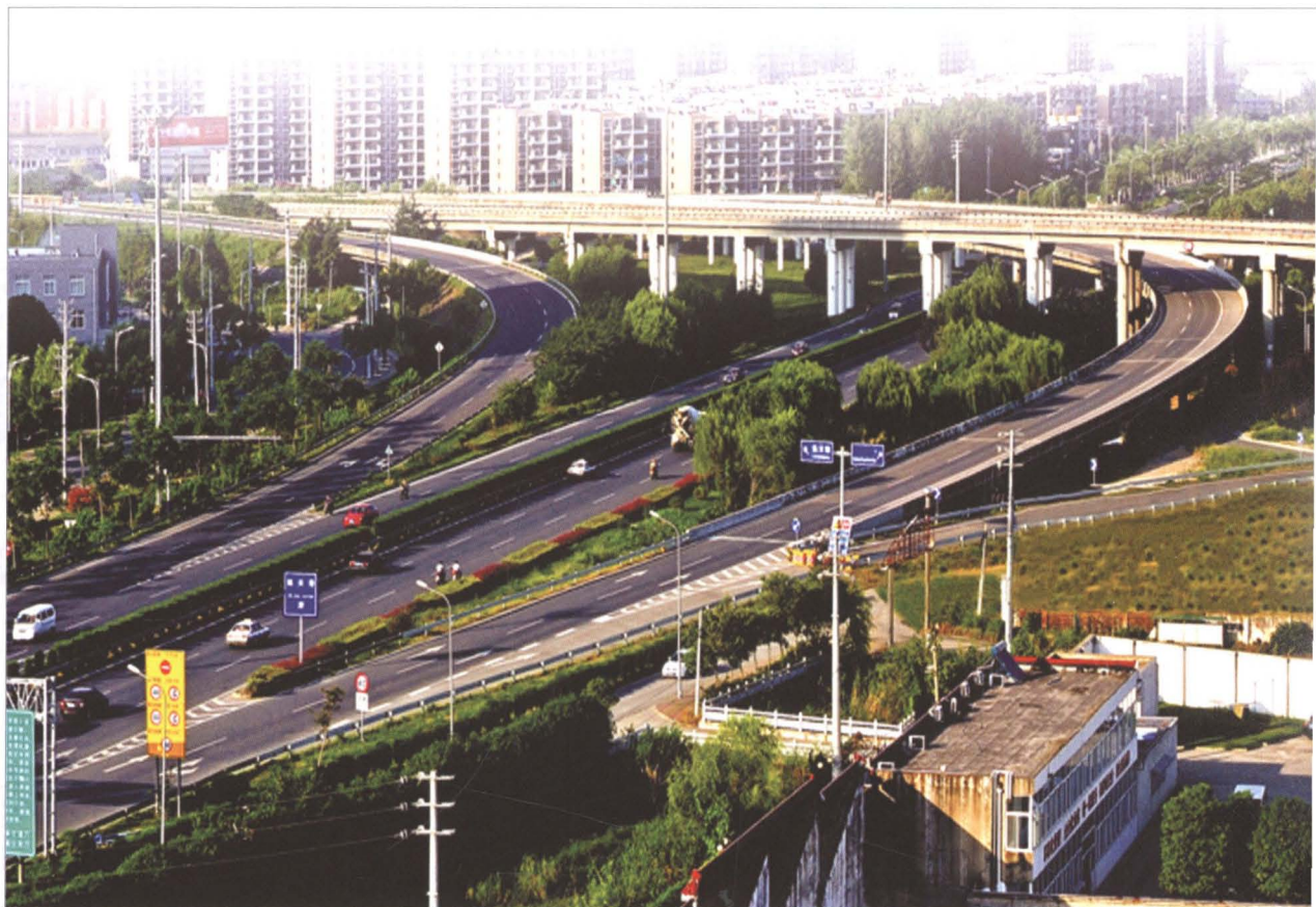
宁连高速龙池互通立交全景
