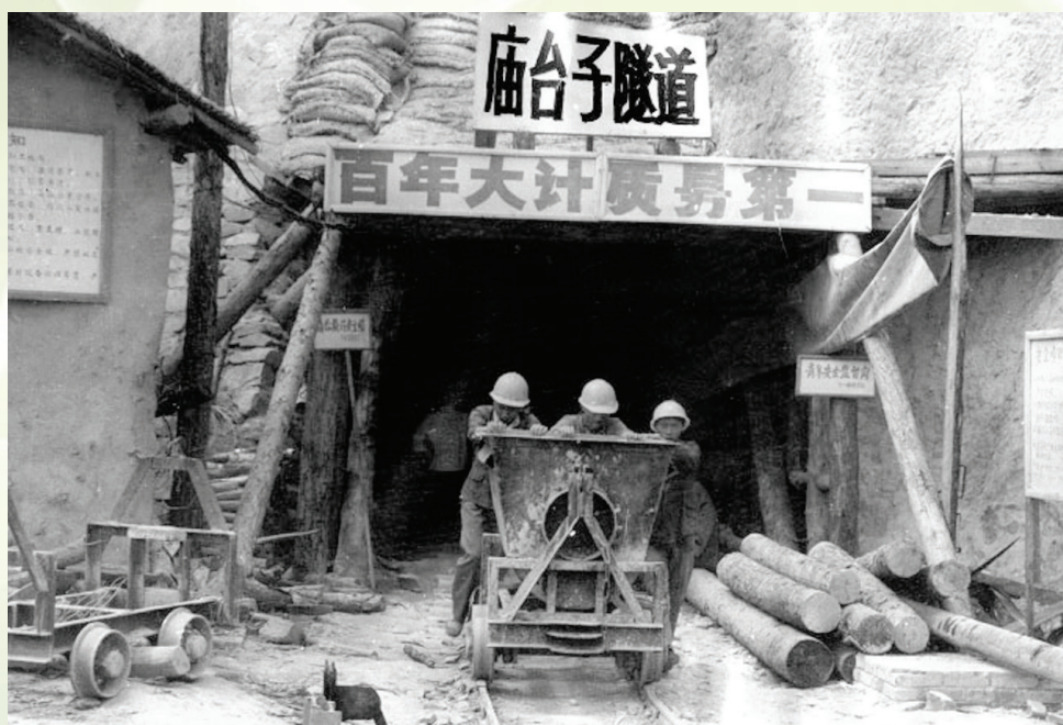
1991年7月庙台子隧道开挖时的工作场景（田国鼎 摄）
