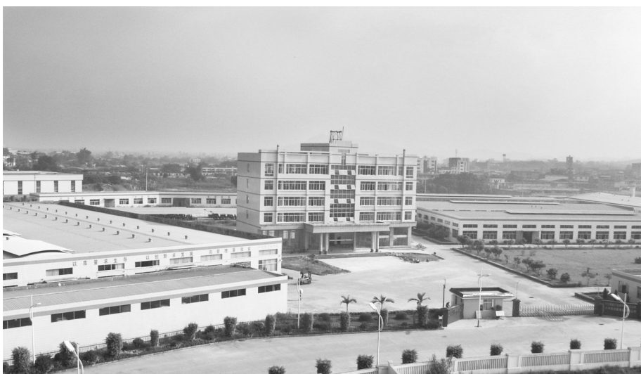
广西正泰印刷包装集团办公楼
