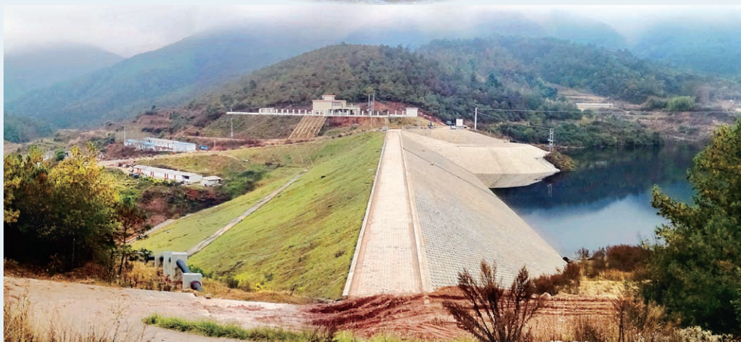
晋宁区酸水塘水库
