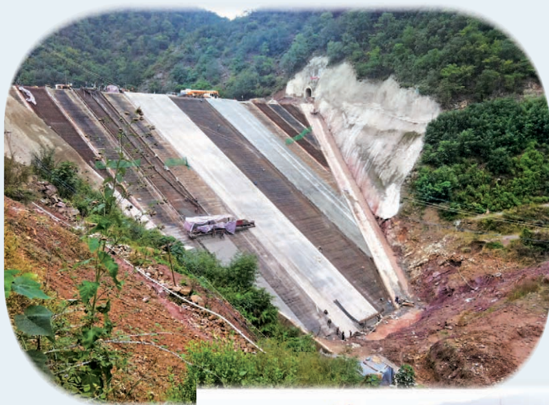
安宁市棕树园 水库面板堆石坝
