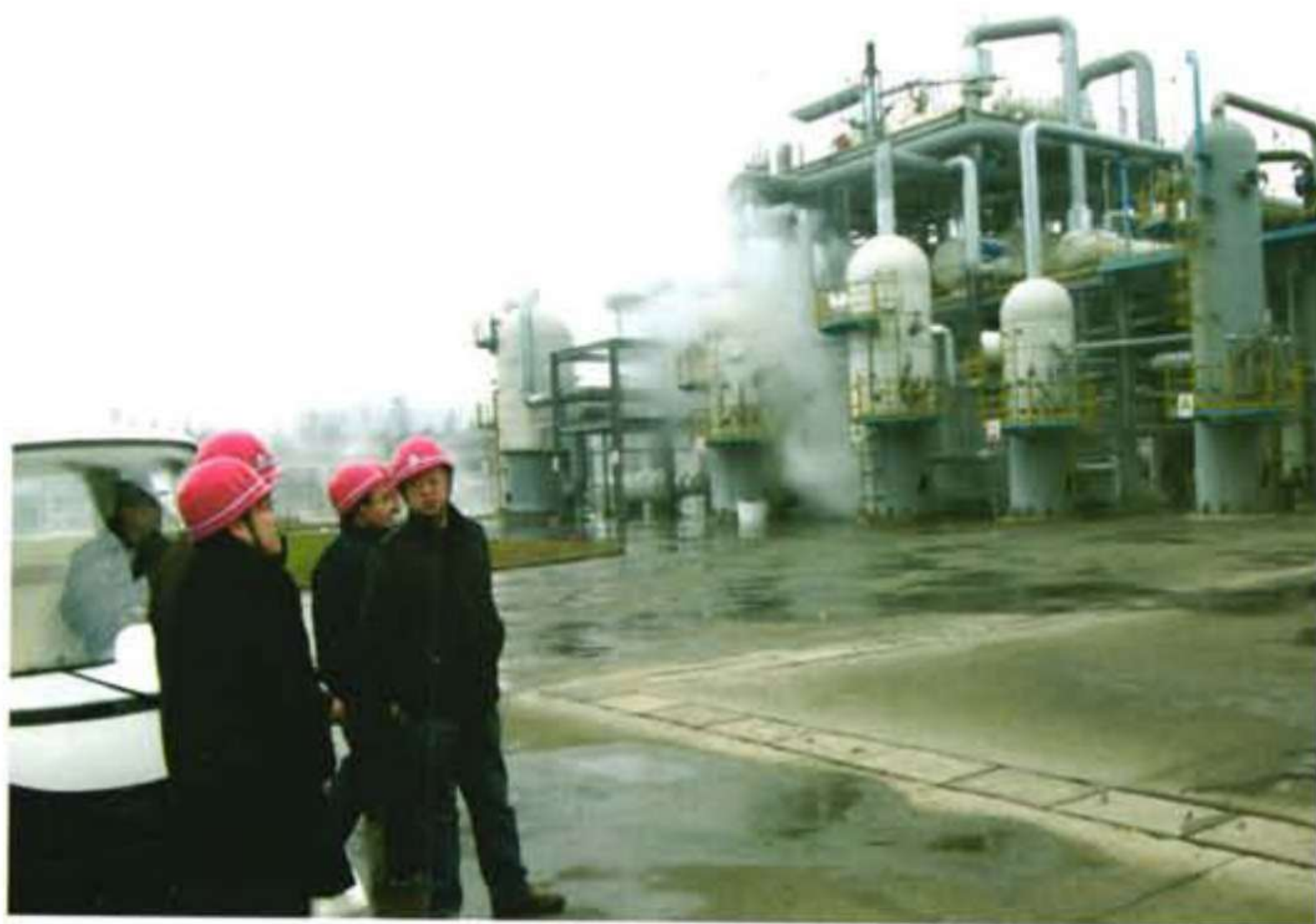
2008年1月凝冻期间，市局执法人员开展“抗凝冻保民生”特种设备执法检查
