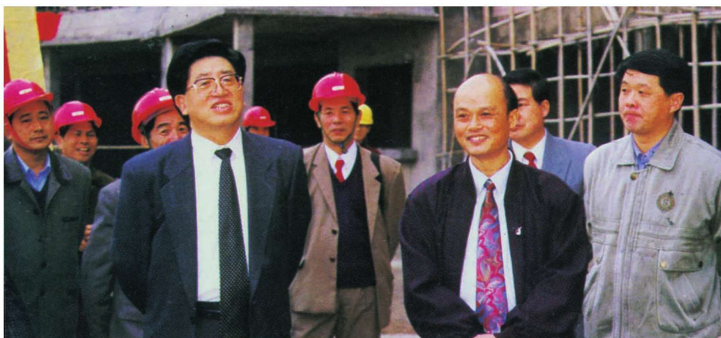
1998年2月15 日，铁道部部长 韩杼滨（前排左 一）视察建设中 的桂林铁路客运 始发站
