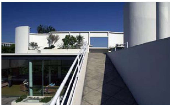
图1-3-18 萨瓦耶别墅，通向屋顶花园
