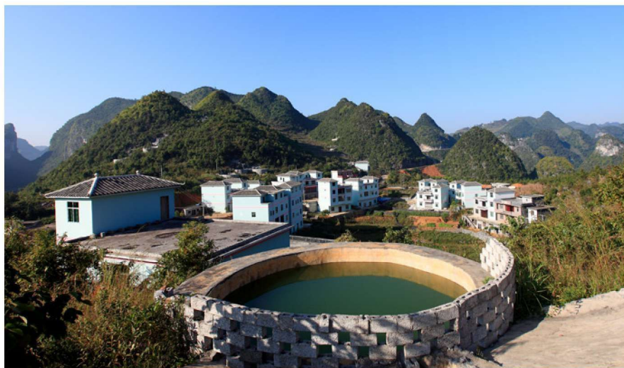
易地安置成为 扶贫攻坚重要手段。 图为大平村客麻峒 易地安置点
