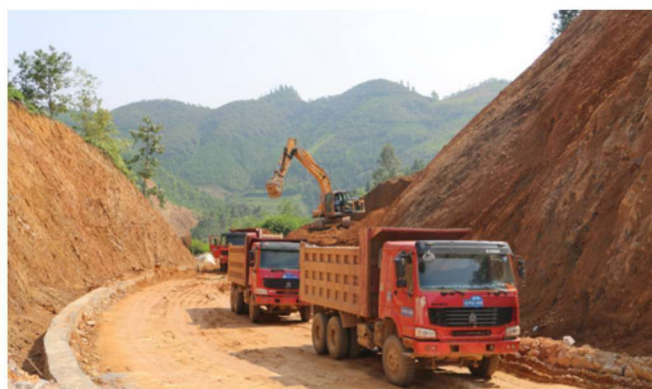
二级公路建设施工现场
