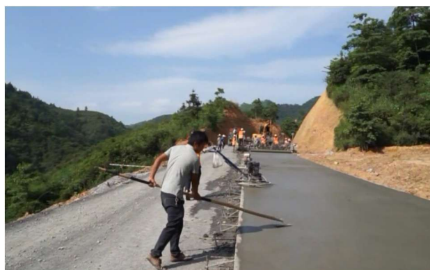
建设中的凤山—凌云二级公路
