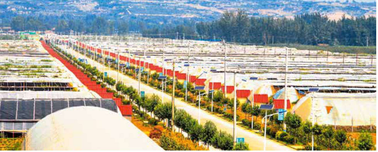
冯村现代农业示范园区
