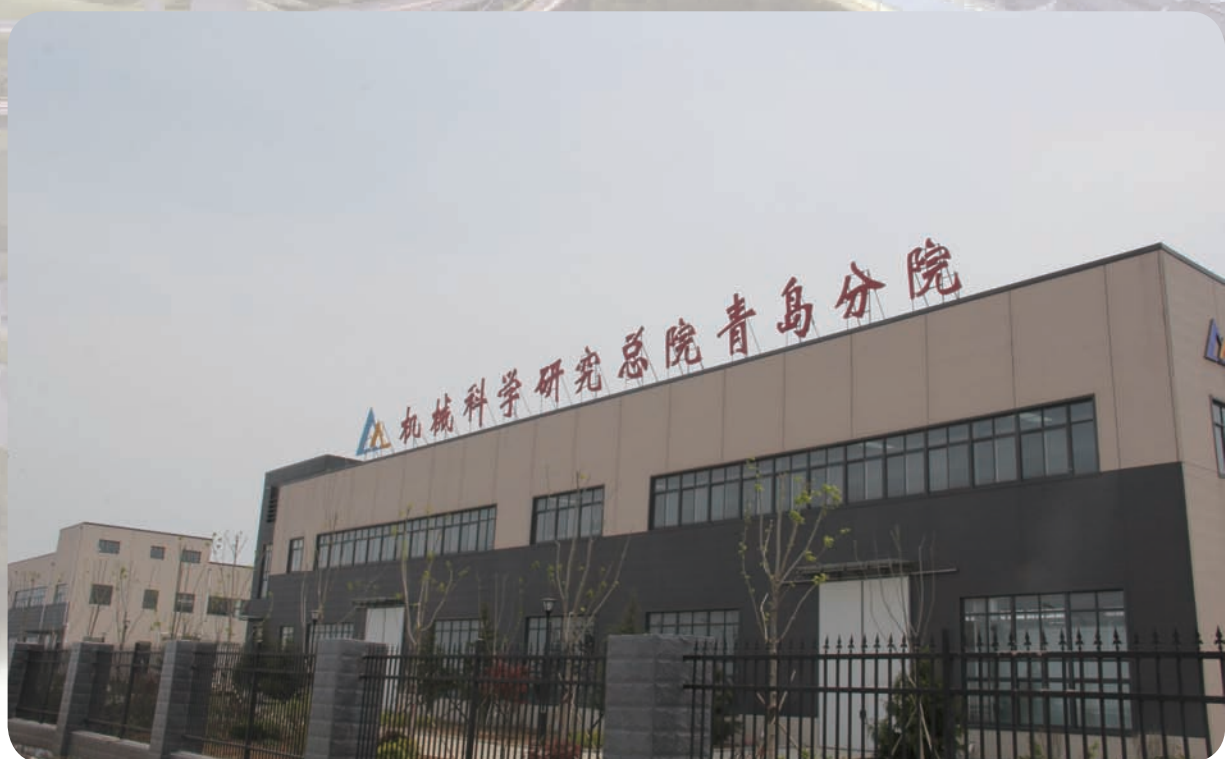
位于国家级胶州经济技术开发区的机械科学研究总院青岛分院。
