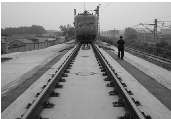
图 1-13 普通板式无砟轨道施工
