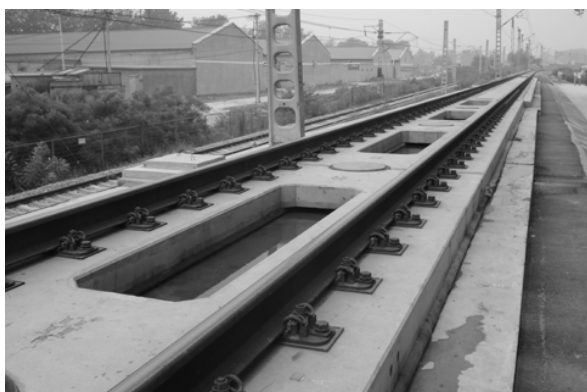
图 1-14 框架型板式无砟轨道
