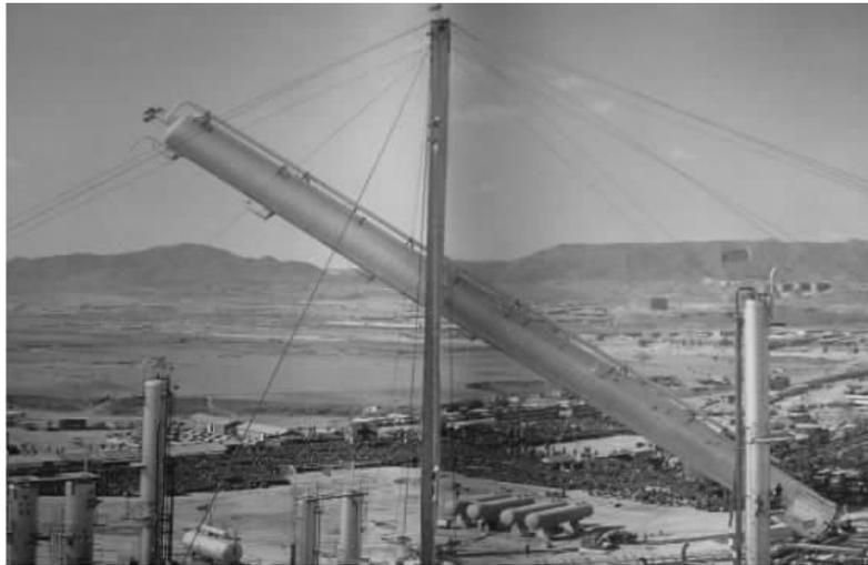
图 0.2 某化工厂反应塔设备吊装
