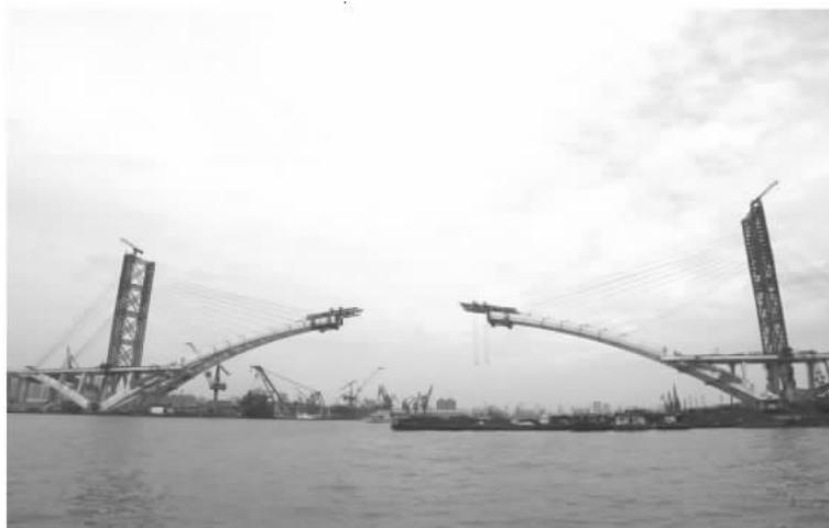
图 0.3 上海卢浦大桥钢管混凝土拱肋吊装
