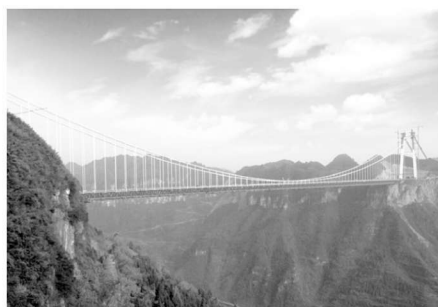
图 1.8 湖南湘西矮寨大桥
