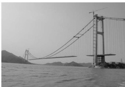
图 1.7 浙江舟山西堠门大桥
