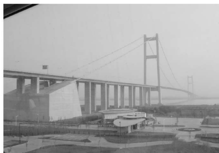
图 1.6 江苏润扬长江大桥
