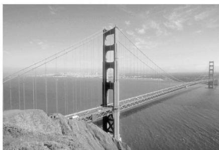
图 1.3 美国旧金山金门大桥
