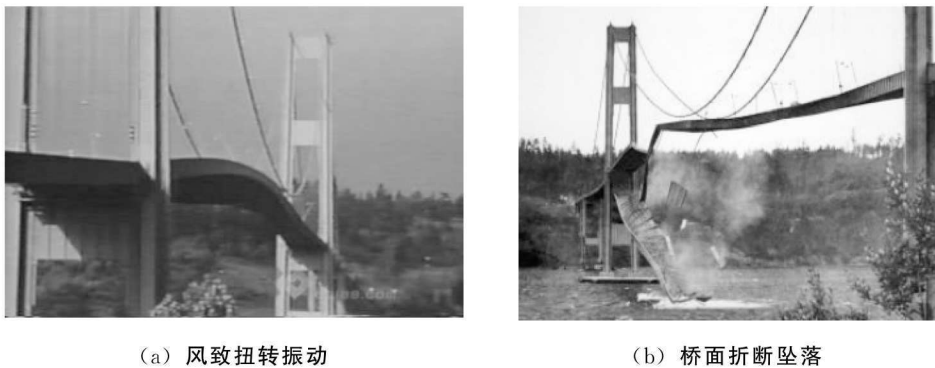
图 1.9 塔科马海峡大桥的风毁
