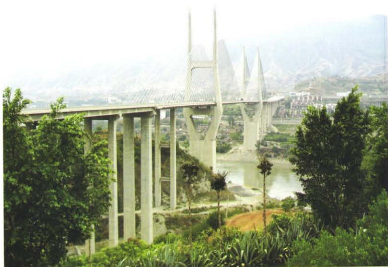
已建成的西攀高速公路金沙江特大桥
