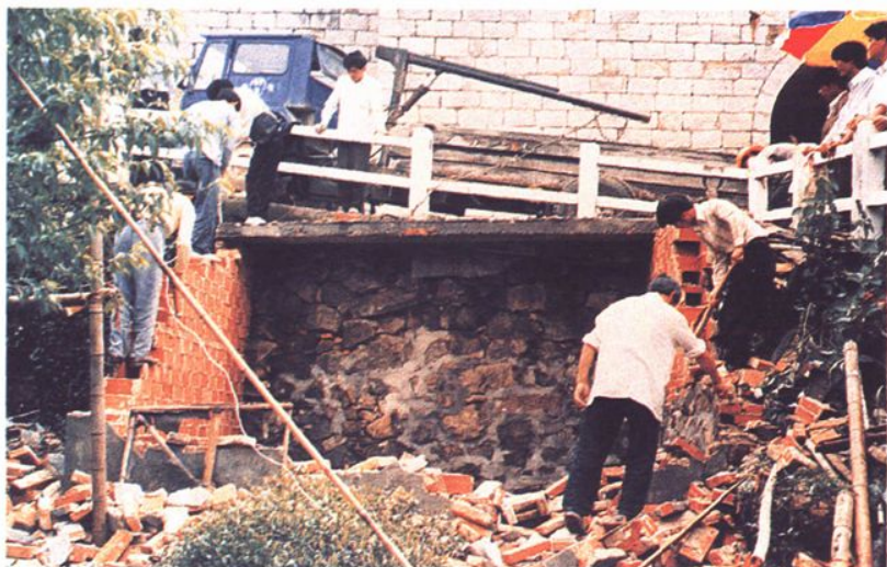
1999年11月17日， 一村民自行拆除违章建 筑物。图为拆除现场
