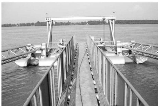
图 1-8 智能型泵站取水构筑物
