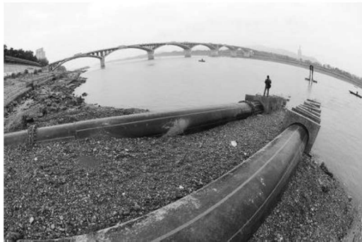
图 1-7 河床式取水构筑物
