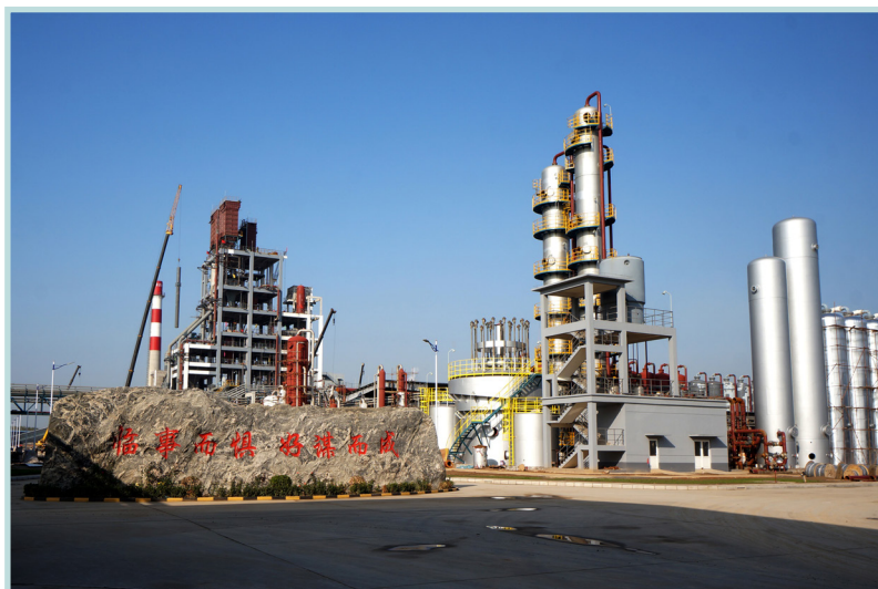
新城化工园区在建的中国昊华河北辛集化工集团生产区（2016 年 11 月 8 日，陈小路 摄）
