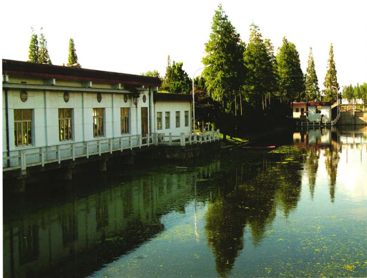
十二圩翻水站建成于 1974 年,1999 年全面除险加固
